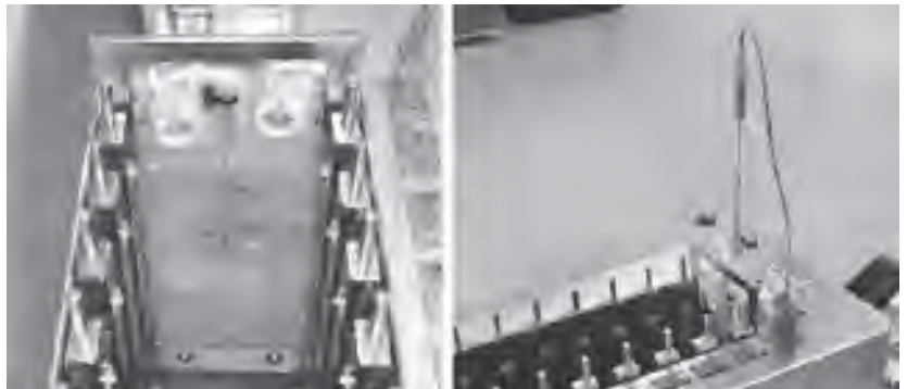
Abbildung 24: Platzierung der Celsius®-Paks und Anschluss der Thermoelemente
